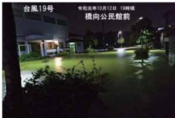
■勝間田川 橋向公民館 浸水状況 (10/12 19:00頃撮影)
