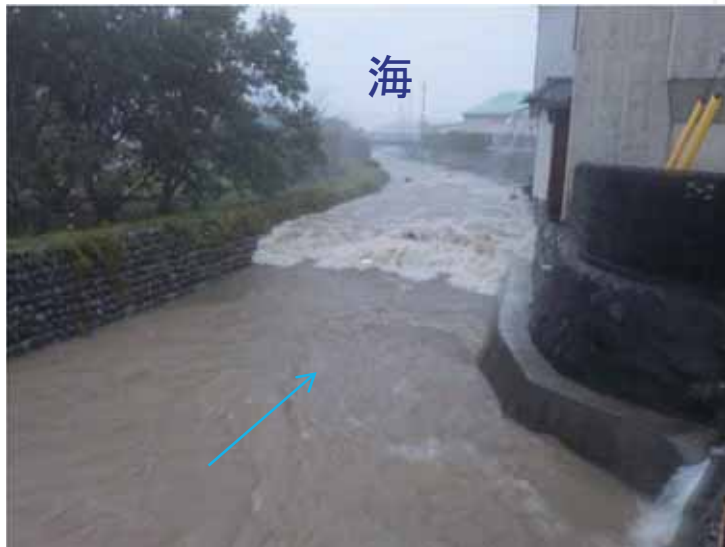
■須々木川 高潮・高波による河川遡上 河口部の水門から約300m地点（10/12撮影）
