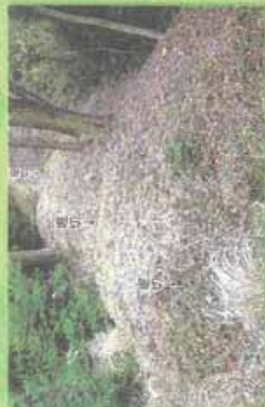
④東尾曲輪切 高く切り取られた石曲輪の断切は、東尾曲輪からの敵軍侵入を防ぎます。東尾曲輪断切は、他に築かれた石曲輪も見られます。
