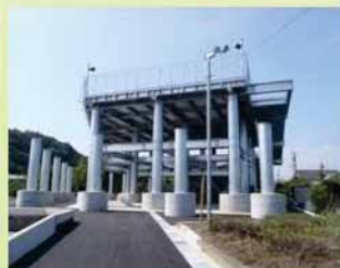
津波避難タワー
