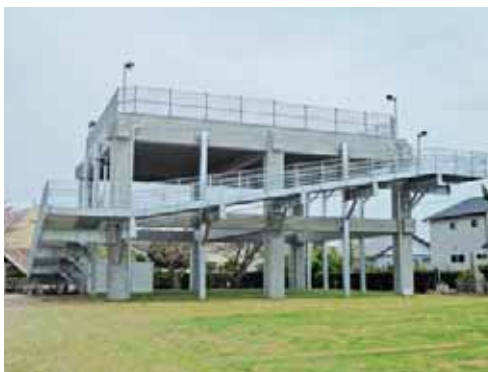
▲津波避難タワー（東慶林公園）
