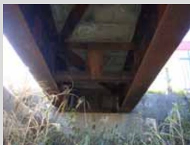
鋼材の腐食（断面膨張）
