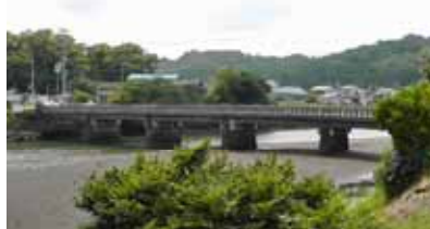
港橋（静波地区）
