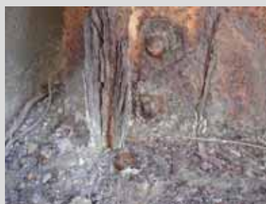
鋼材の腐食（断面膨張）
