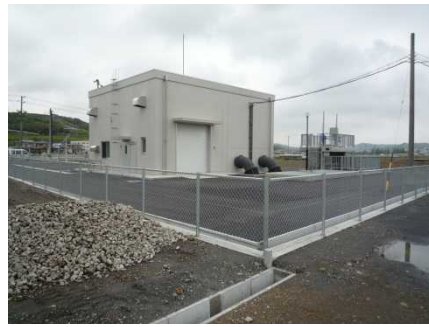
榛原第2排水機場
