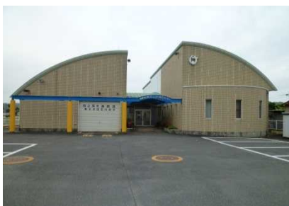
川崎コミュニティ防災センター
