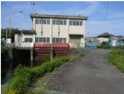
榛原第1排水機場
