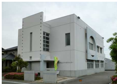
片浜コミュニティ防災センター
