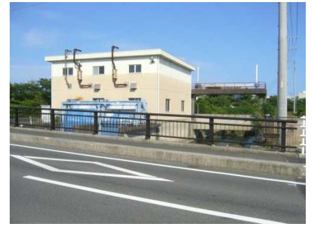
庄内排水機場
