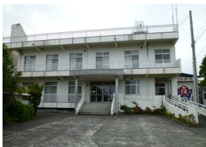
大江コミュニティ防災センター
