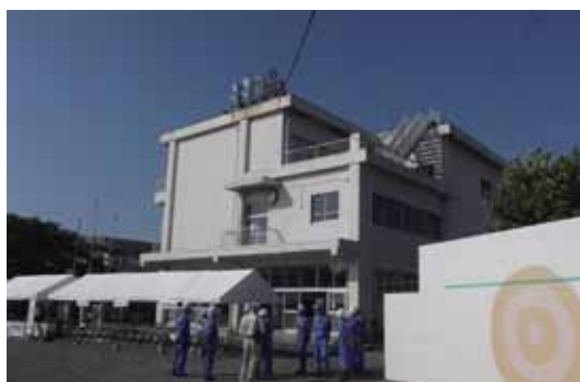
細江小学校の屋上への避難
