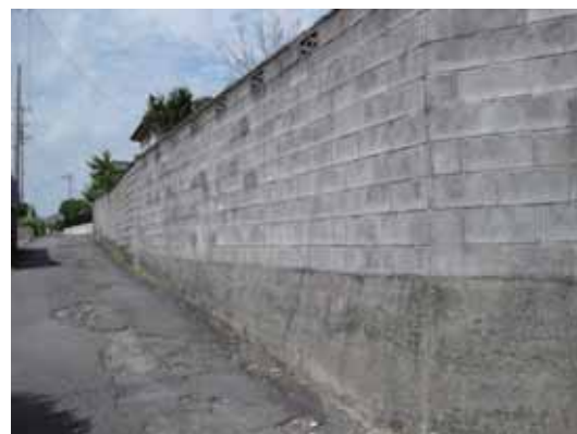
ブロック塀の改修
