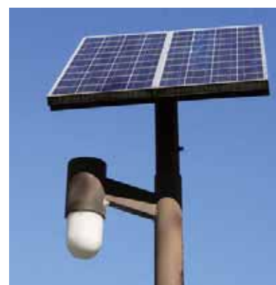
自然エネルギーによる照明の設置
