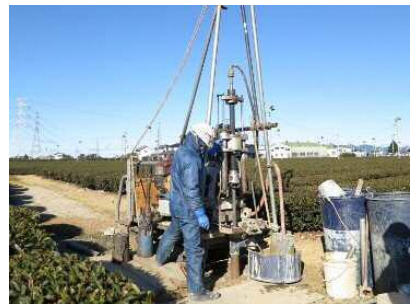
▲ボーリング調査
