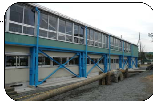
【耐震補強工事後の相良小学校体育館】
