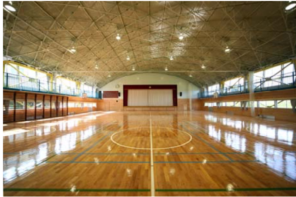
▲完成した勝間田小学校 体育館
