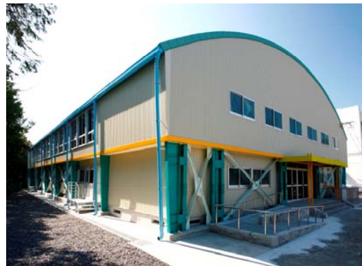
▲萩間小学校の体育館
