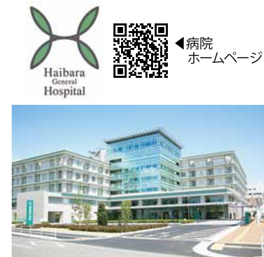
榛原総合病院外観
