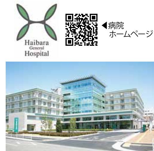
榛原総合病院外観
