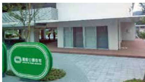
女川陸上競技場跡に建てられた鉄筋の災害公営住宅
