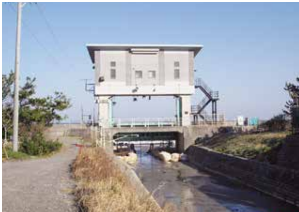
遠隔操作で管理されている地代川の水門
