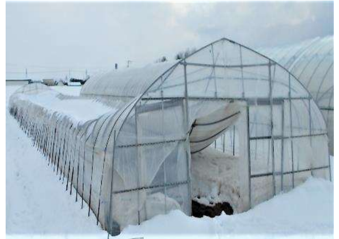
＜雪による被害の様子＞
