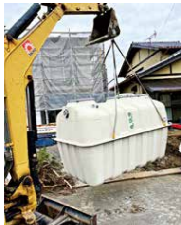
浄化槽の設置工事
