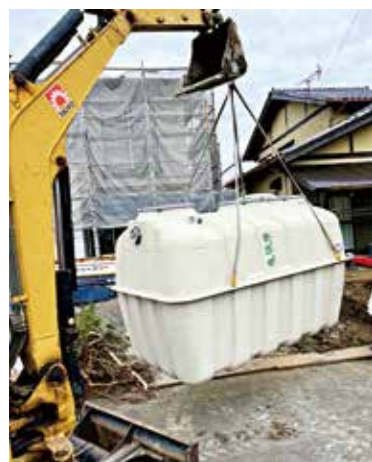
浄化槽の設置工事
