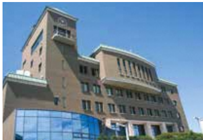
市役所榛原庁舎
