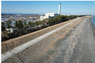
細江海岸レベル2防潮堤整備工事
