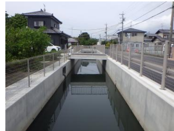
準用河川沢垂川改修工事
