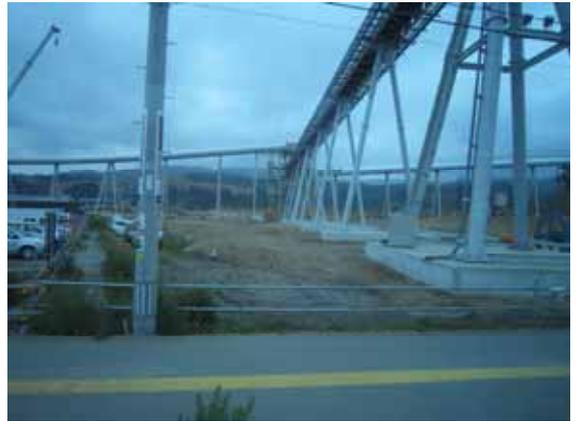
大量の土砂を運搬するベルトコンベアー
