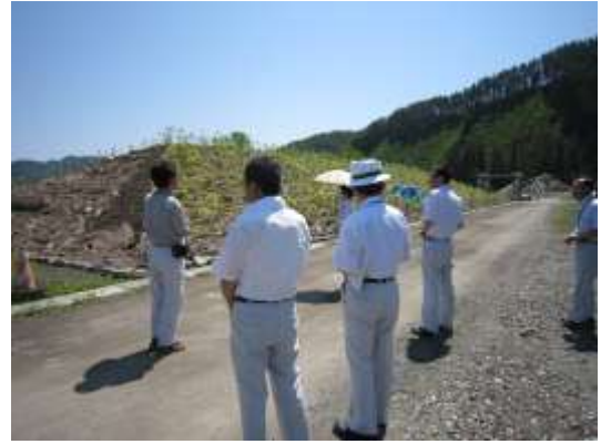
大槌町 「いのちを守る防潮堤」
