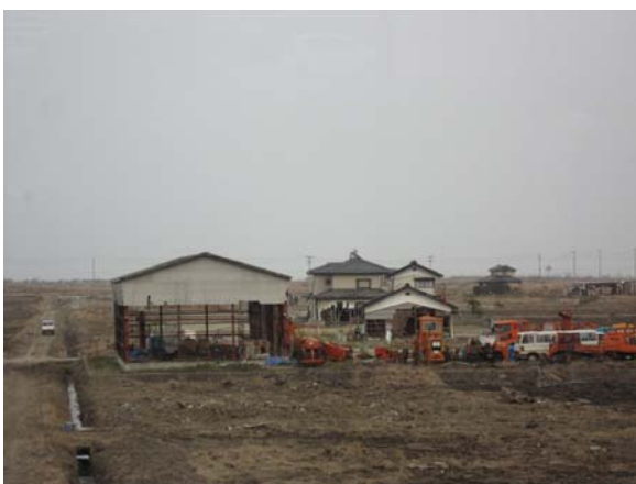
津波による被害
