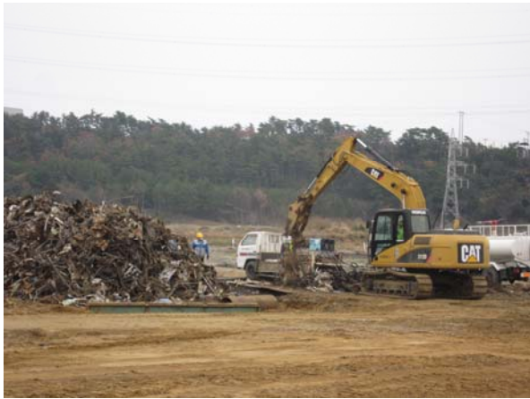
ガレキ処分の作業中
