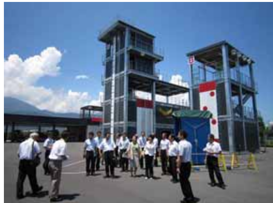
南アルプス市消防庁舎訓練塔
