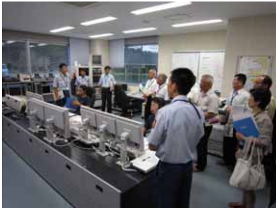
白浜町消防庁舎通信司令室
