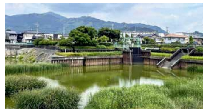
雨水を貯留しポンプで排水する内水氾濫対策施設「静岡市 押切南調整池」
