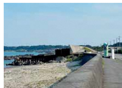
地頭方地区の防潮堤工事
