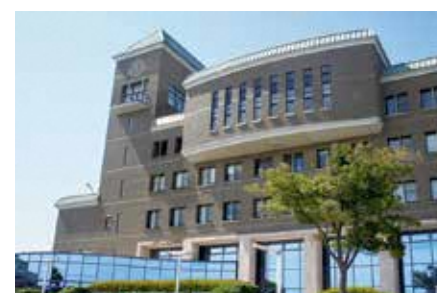
市役所榛原庁舎
