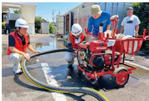
可搬ポンプの操作訓練（片浜区）
