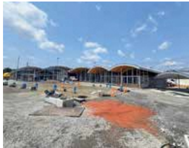
7月にオープン予定のそらっと(令和7年4月現在の現地写真)
