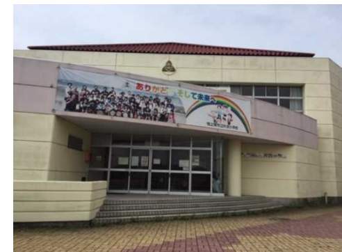
主要建物の外観
