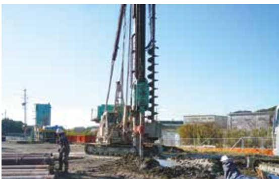
津波避難タワー杭基礎工事
