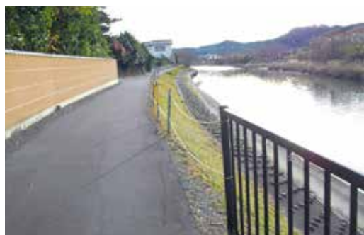
改良が進む、勝間田川左岸堤防
