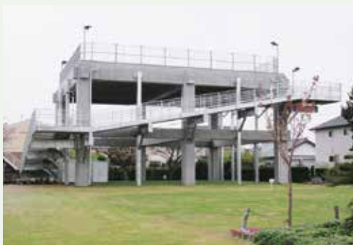
昨年3月細江区内に完成した津波避難タワー
