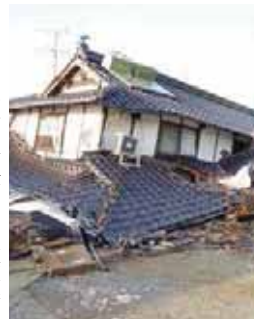
倒壊した家屋から身を守るためにも耐震シェルターを
