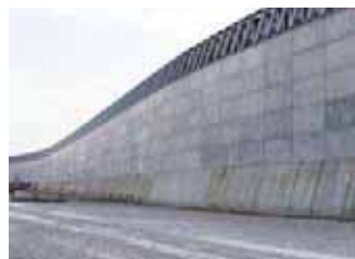
完成した防波壁
