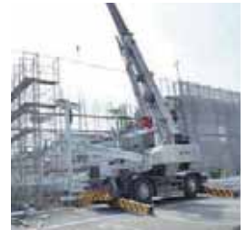
建設中の津波避難タワー
