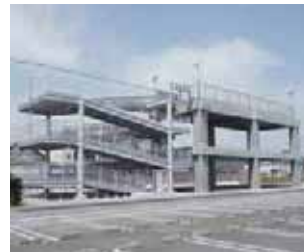
津波避難タワーGブロック(橋原交番南側)
