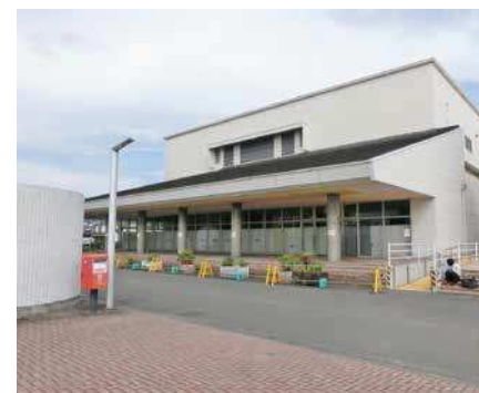
除却が予定されている榛原文化センター（ホール棟）
