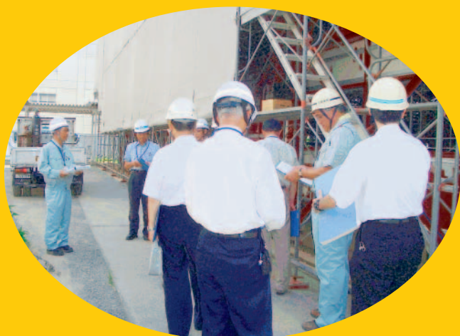
文教厚生委員会が相良小学校の 体育館耐震工事を視察
