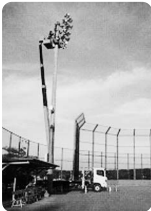
安全に利用できるよう施設の点検や改修に努力を(相良総合グラウンド)
