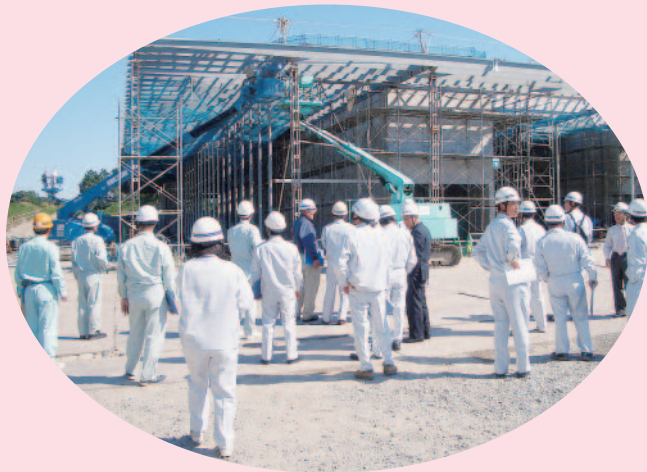
建設たけなわの相良総合センターを全議員で視察した。
