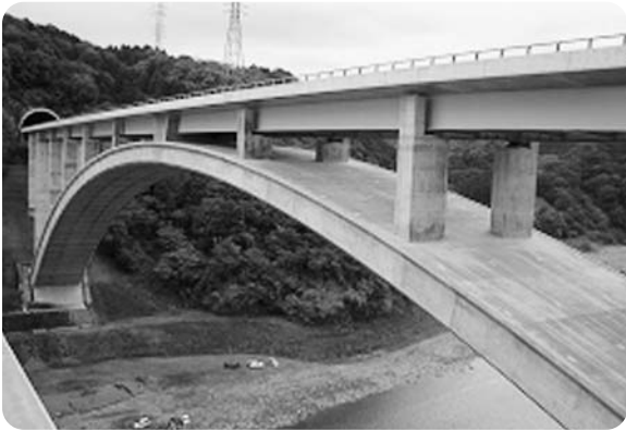
【富士川橋】265mのアーチスパンは日本最大
