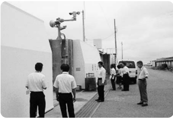
遠隔操作による陸閘の開閉を確認
