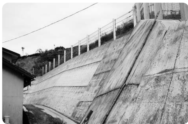
最近完成した急傾斜地崩壊防止対策事業
