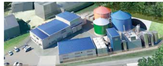
牧ノ原バイオガス発電所：運営（株）ゲネシス
