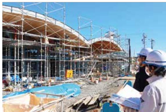
【建築技術員】建築物の施工管理（写真は道の駅）
