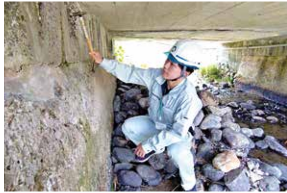
【土木技術員】橋梁点検で損傷状況を確認
