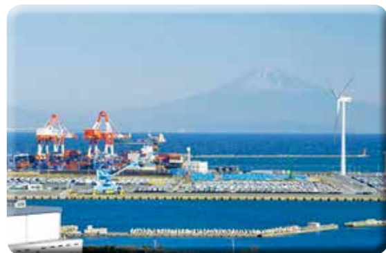
御前崎港への客船誘致が期待される
