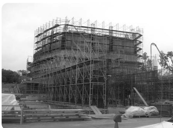
電源交付金等の財源で建設中の総合センター
