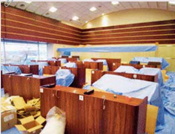
議場音響改修工事の様子
