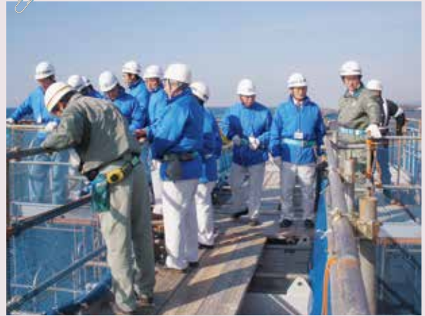
浜岡原子力発電所の防波壁を視察 (全議員)
