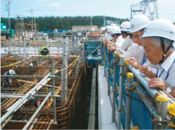
浜岡原子力発電所の津波対策工事の現場視察 (全議員)
