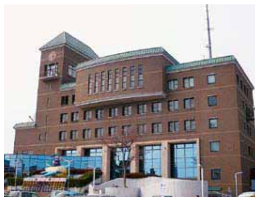
榛原庁舎（平成6年2月建築 16年経過）
