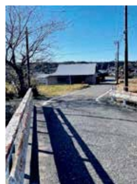
歩道のない拡幅が必要な通学路
