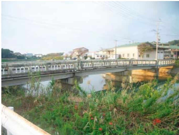
昭和7年に建設され、老朽化が目立つ後川橋
