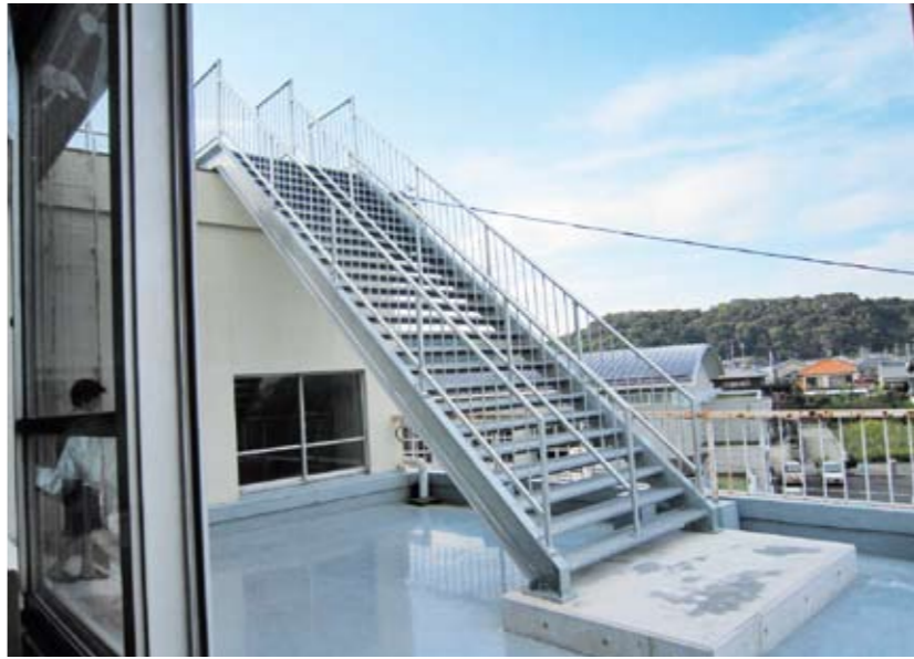
細江小学校の緊急避難用階段
