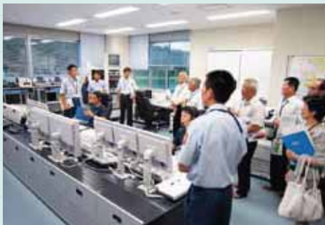
白浜町消防庁舎通信司令室
