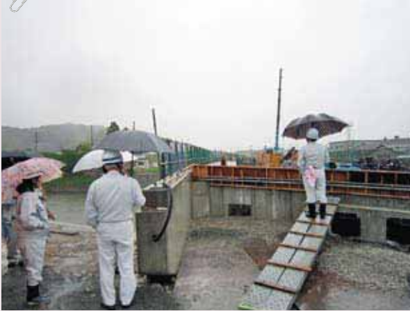
架け替え中の山の手幹線「深谷橋」を視察 (総務建設委員会)
