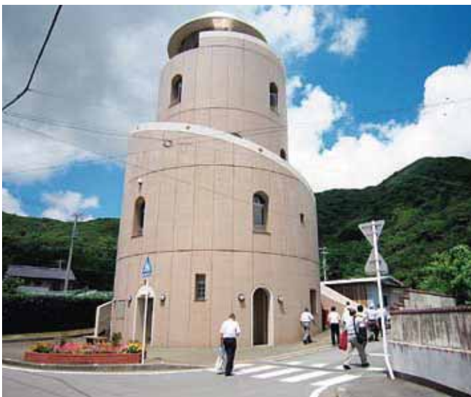
津波被害から人命を守る「安心の塔」(大紀町錦タワー)
