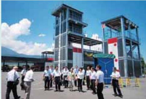
南アルプス市消防庁舎訓練塔
