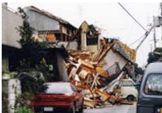
道路への家屋倒壊
