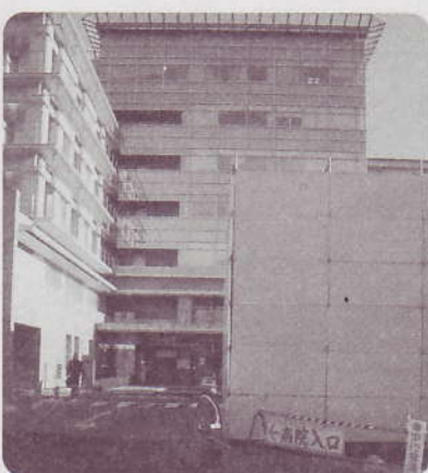
完成間近の榛原総合病院
