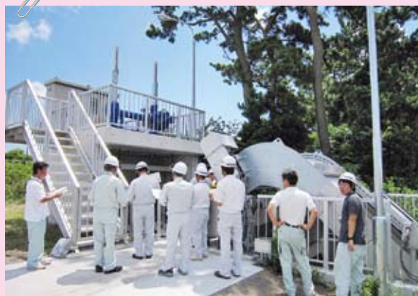
坂口谷川河口湛水防除施設の現地視察（総務建設委員会）
