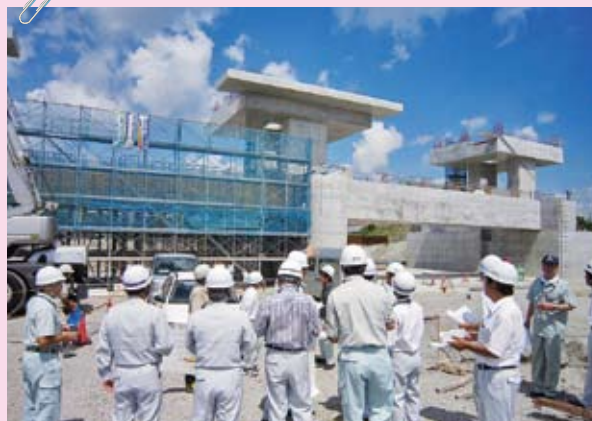
勝間田川耐震水門の現地視察（総務建設委員会）
