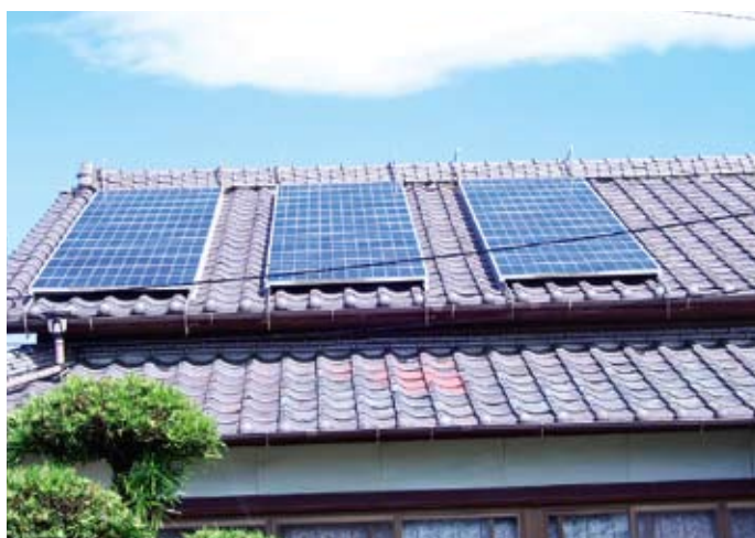
太陽光発電設置住宅
