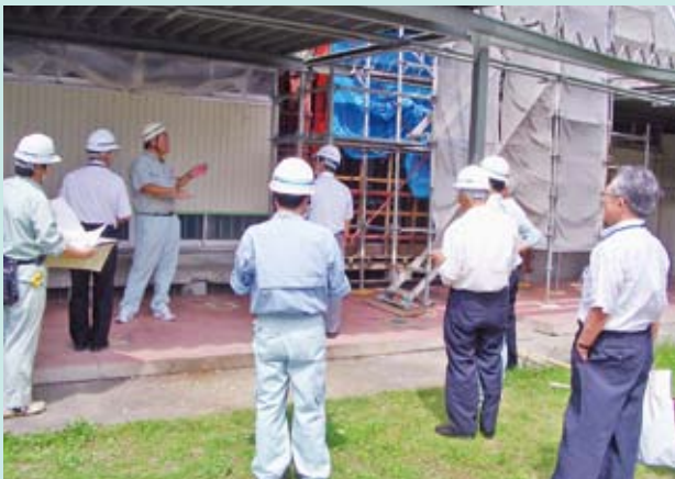
文教厚生委員会が耐震補強工事現場を視察
