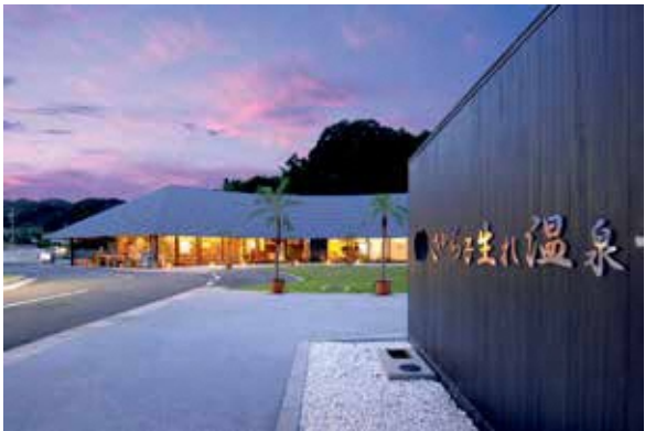
工事が予定されるさがら子生れ温泉会館
