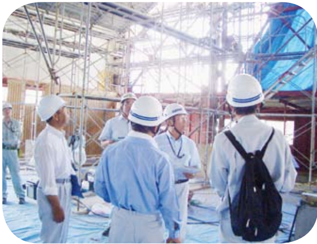
文教厚生委員会が 小学校体育館耐震工事の現場を視察
